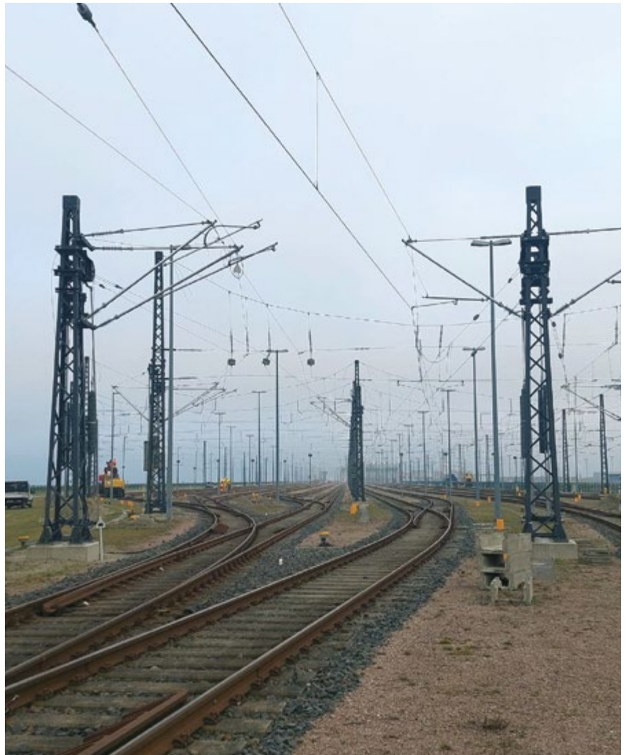
Bild 8: Querfelder mit Gewichtssteinen und Arbeitsgrenzschildern zur Teilinbetriebnahme Dezember 2022
