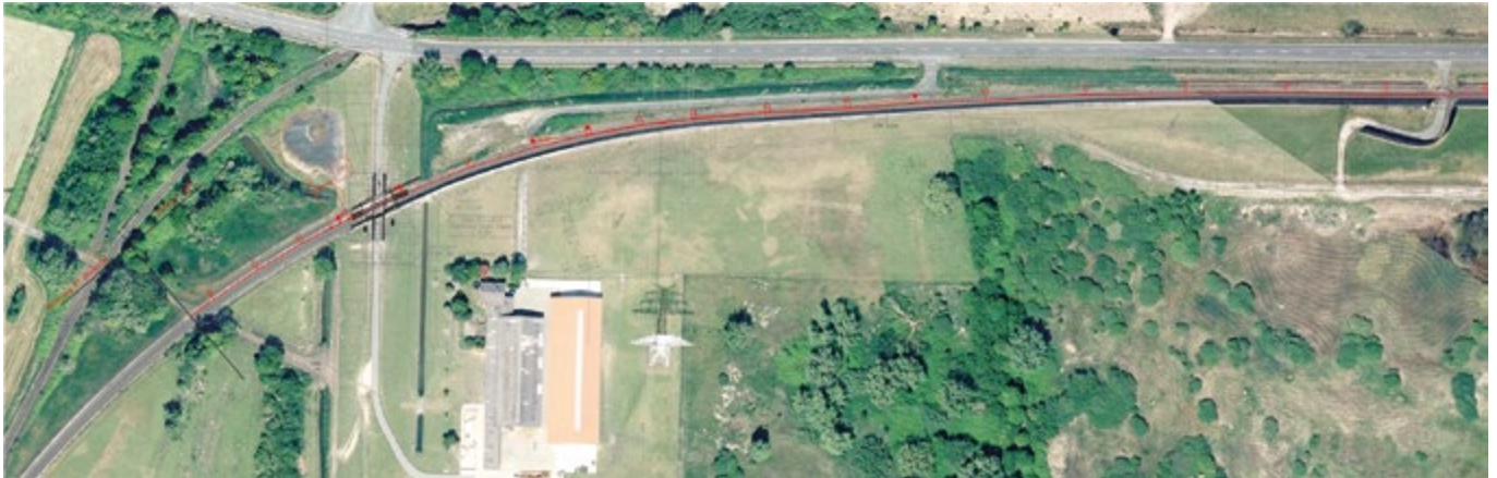
■ Bild 5: Zuführgleis mit Anschluss an das Netz der DB AG
