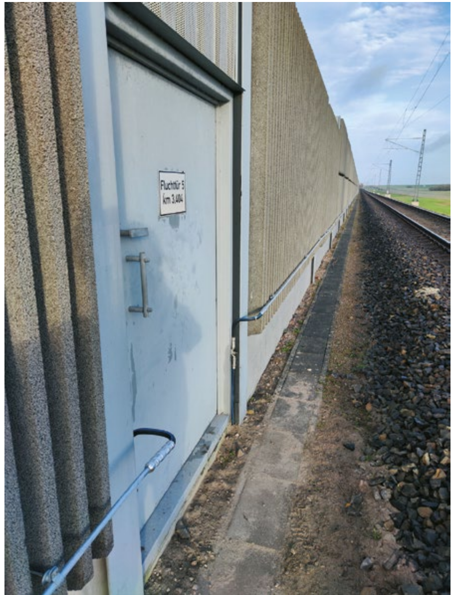
■ Bild 3: Prelleiter an Lärmschutzwand und Fluchttür
