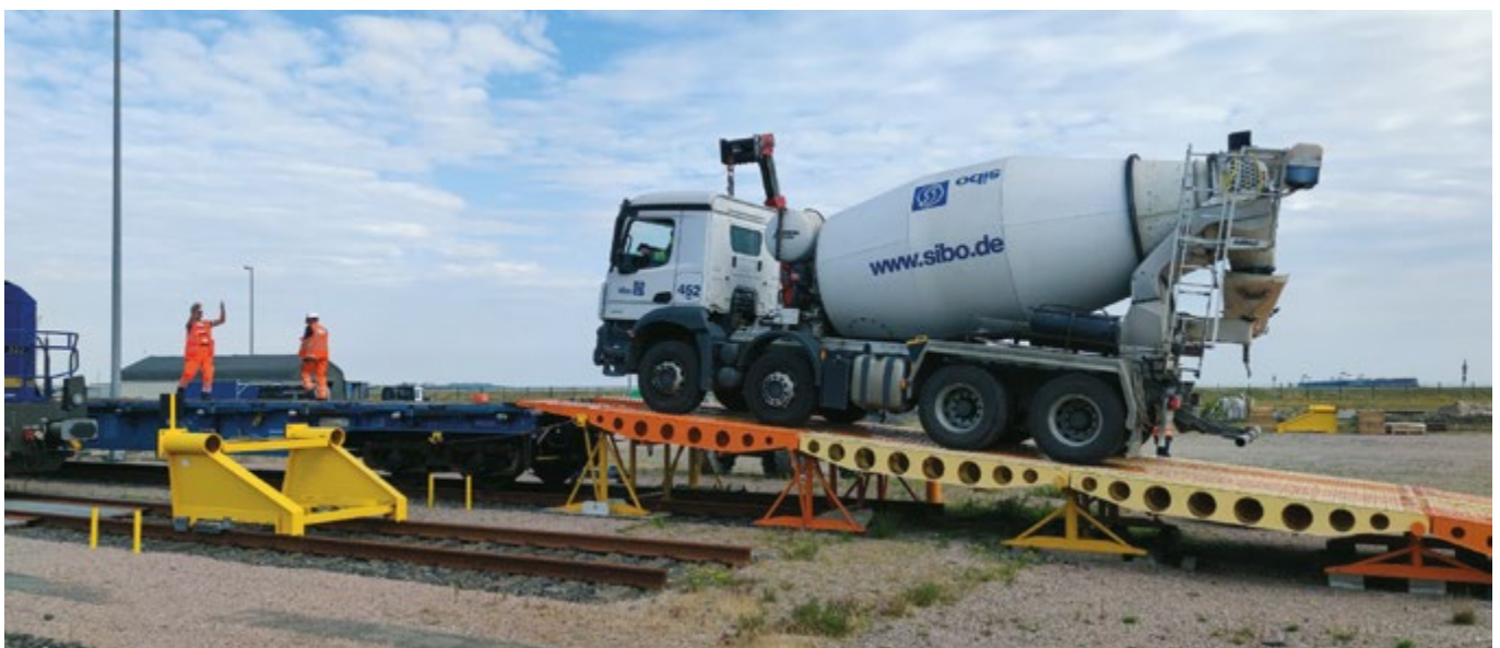
■ Bild 4: Betonverladung mittels ehemaliger Panzerrampe
