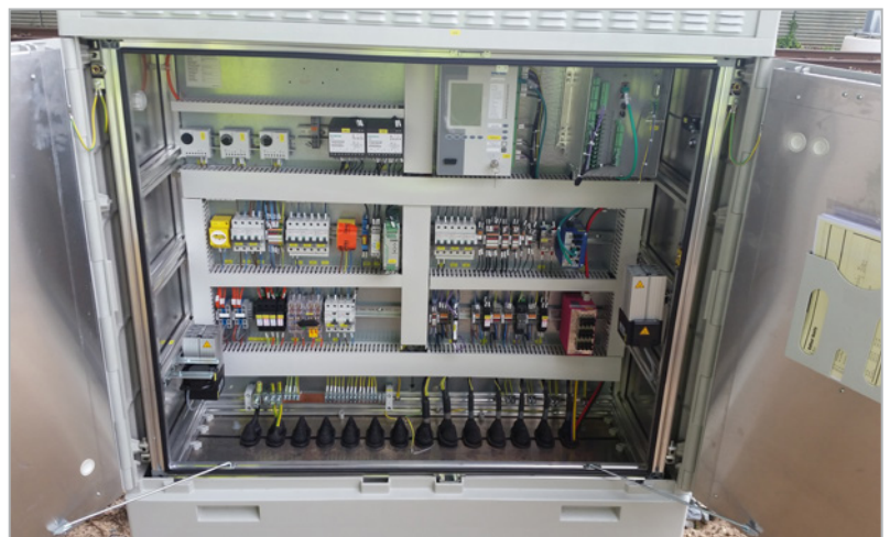
Bild 4: Gleisseitiger Erfassungsschrank.
