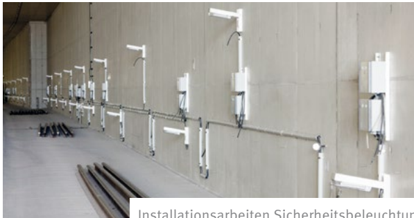
Installationsarbeiten Sicherheitsbeleuchtung
