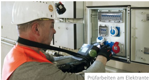
Prüfarbeiten am Elektranten
